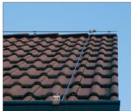
Bild 11: Verbindung von Dachfirst mit Regenrinne
