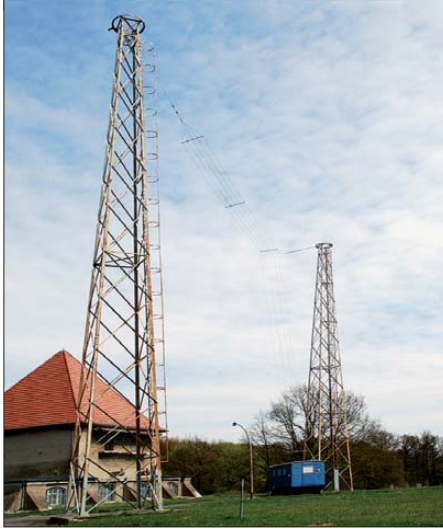
Die T-Antenne ist an 30 m hohen Kontertürmen befestigt. Sie dienen ursprünglich zum Abfangen der Speiseleitungen von Drahtantennen. Foto: Archiv
