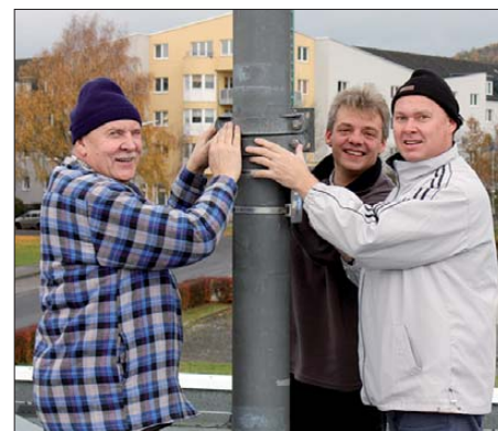
Hans, DG4EZ, Thilo, DL9CE, und Jochen, DL1YBL, bei Montagearbeiten zur Errichtung der Antenne von DB0AFZ beim DARC-AFZ. Foto: DL1YBL
