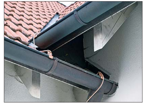
Bild 4: Kopplung einer Ableitung mit einer Kupferregenrinne
