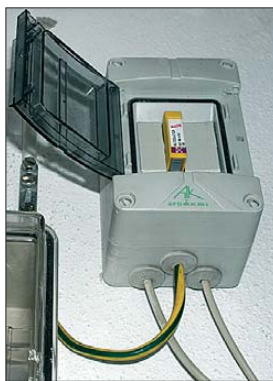
Bild 8: Dehn-Überspannungsableitung für Telefonanschluss, DSL-tauglich, in eigenem Hutschienengehäuse
