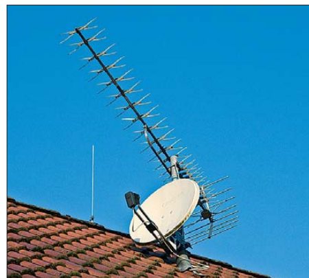
Bild 10: Das auf dem Dachfirst ist keine Groundplane, sondern die Blitzfangstange, die oberhalb der TV-Antennenanlage montiert ist. Fotos: DL2MCD
