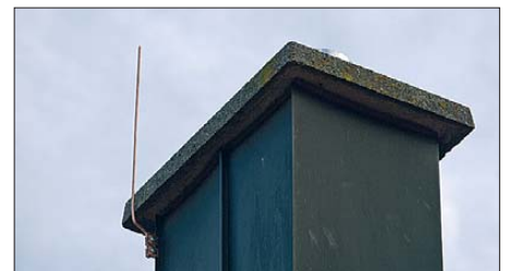
Bild 5: Fangspitze (1 m) am Schornstein
