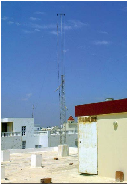
So fanden wir das Dach vor! Ein Beam und jeweils eine Groundplane für 40 m und 80 m schienen als Maximum möglich.
